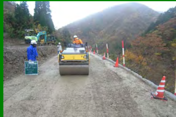
補強土壁施工状況
