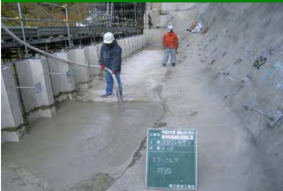
エアームルク施工状況
