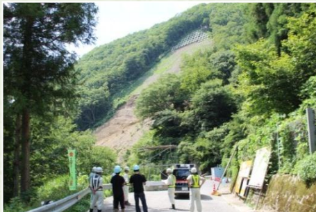
八草川では、崩壊地の安定化を図る山腹工事を見学 (施工：(株)久保田工務店)
