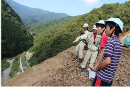
高地谷では、付替林道の切土法面の掘削状況を見学 (施工：西濃建設(株))
