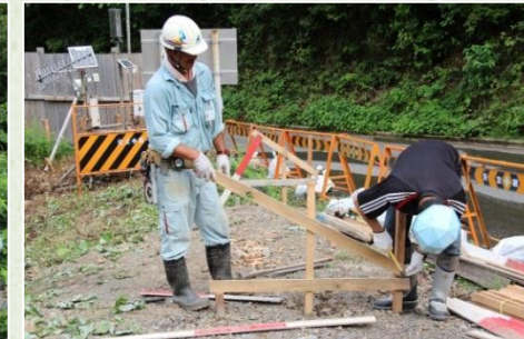
大井谷では、工事現場に欠かせない丁張りの設置や、重機の操作を体験 (施工：田中建設工業(株))
