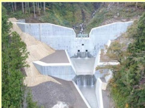
下河原谷第1砂防堰堤 全景
