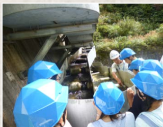
山の谷第1砂防堰堤 (揖斐川町坂内諸家)
