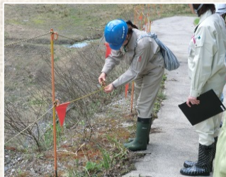
敷原谷第1砂防堰堤を点検
