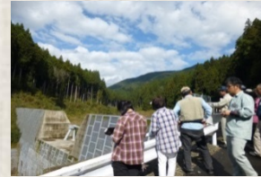
敷原谷第1砂防堰堤
