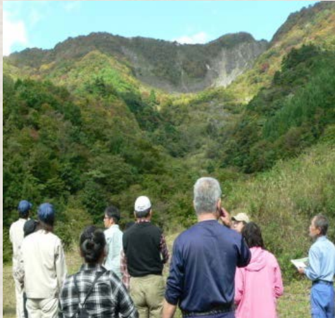
根尾白谷崩壊地
