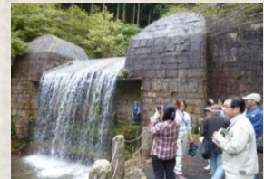
鷺巣谷第1砂防堰堤
