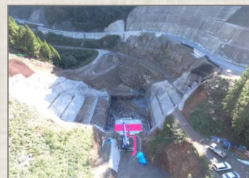
急峻な谷間の工事現場
