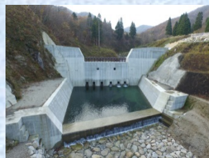
完成写真 (地谷第2砂防堰堤)
