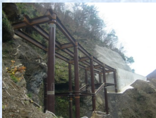
完成写真 (大谷川第3砂防堰堤道路)
