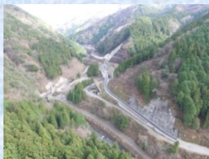
完成写真 (高地谷第1砂防堰堤道路)
