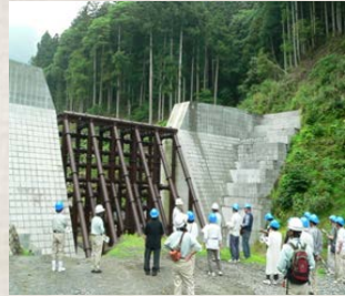
大蔵谷第1砂防堰堤見学
