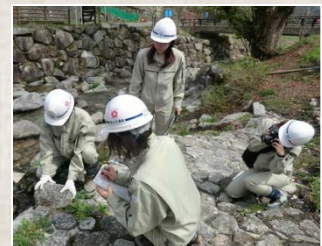
点検状況(貝月谷溪流保全工)
