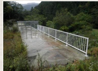
転落防止柵の設置(根尾・大井谷)
