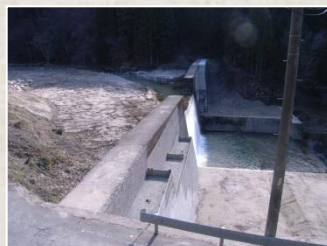
工事が進む品又第1砂防堰堤
