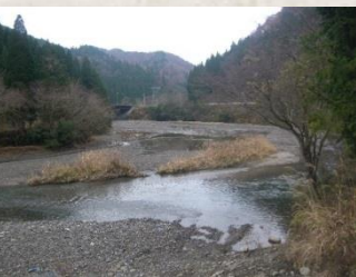
坂内砂防堰堤の堆積土砂撤去
