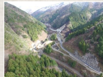
林道の付替が完了
