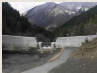
寒谷第1砂防堰堤
