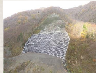
法面復旧が進む (八草川の山腹復旧)
