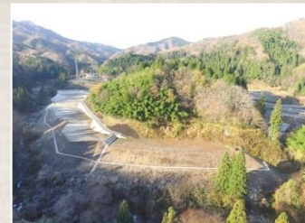
工事残土で基盤整備を実施 (坂内諸家地区)
