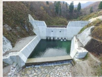
地谷第2砂防堰堤
