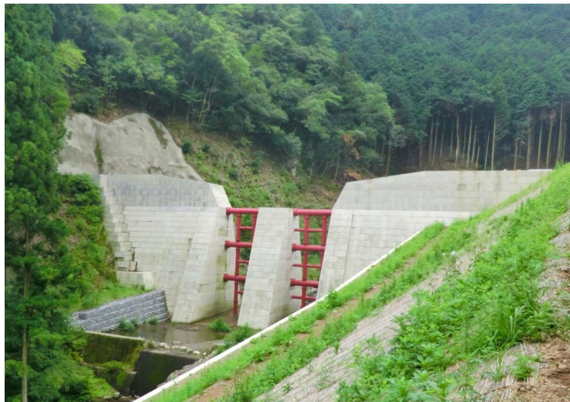
宇津志谷第1砂防堰堤を下流から望む
