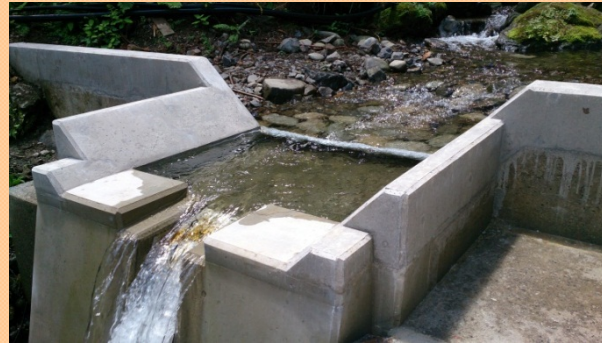
改修した取水堰
