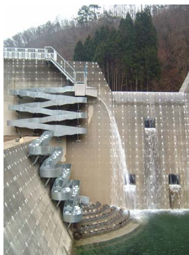
高低差の大きな箇所専用の 「たて型壁面魚道」
