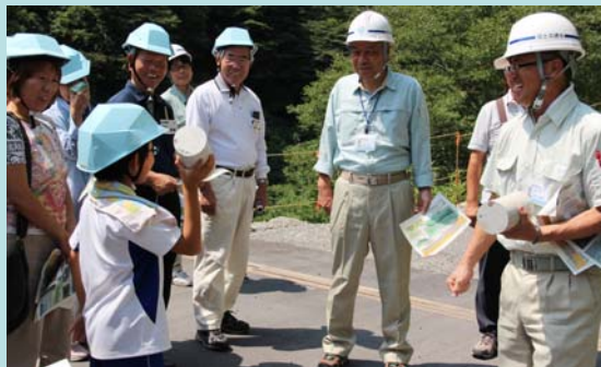
＜大谷川第3砂防堰堤道路工事現場＞
