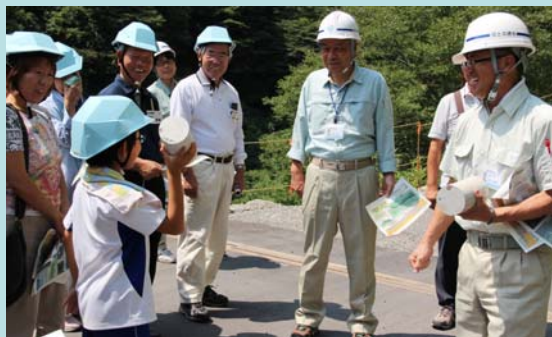
<大谷川第3砂防堰堤道路工事現場>
