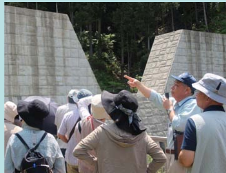
<下谷第1砂防堰堤見学>
