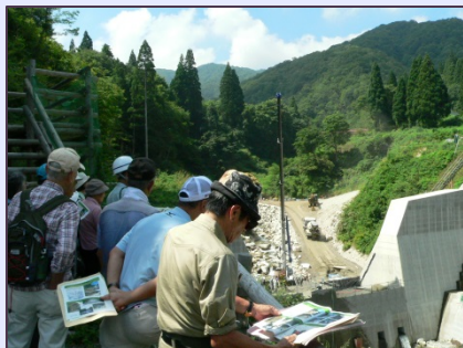
地谷第2砂防堰堤工事現場
