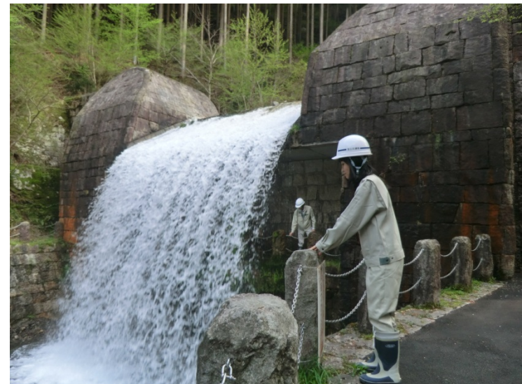
(鷲津谷第1砂防堰堤：本巢市根尾神所)
