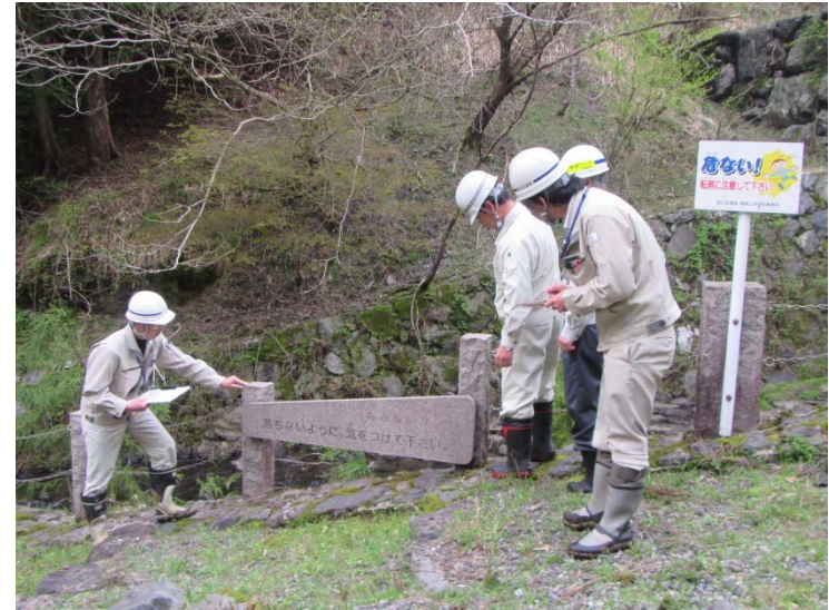
(下辻谷第2砂防堰堤：揖斐川町小津)
