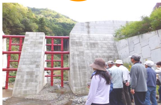
宇津志谷第1砂防堰堤
