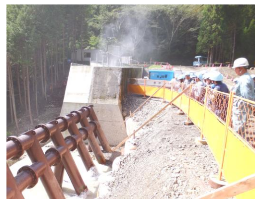
流木対策工事現場(根尾上葛谷)
