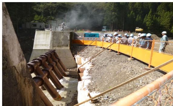
＜流木対策工事(上葛谷工区)＞
