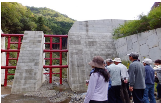
＜宇津志谷第1砂防堰堤＞
