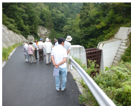
＜瀬戸谷1砂防堰堤＞
