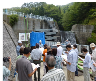
＜山の谷第1砂防堰堤＞
