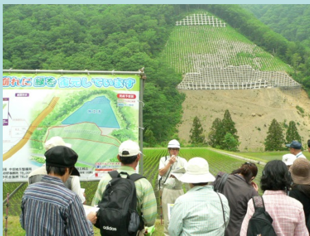
<八草川山腹工工事見学>
