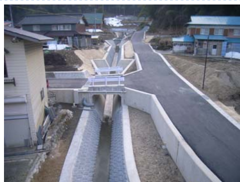
完成した「ドン谷溪流保全工」
