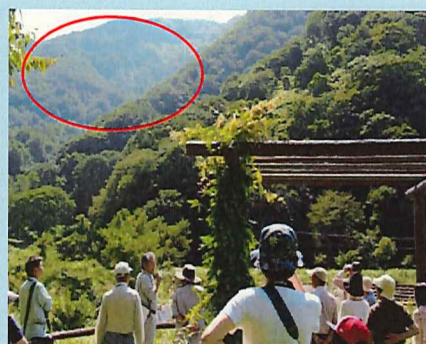
※崩壊地(写真奥)
