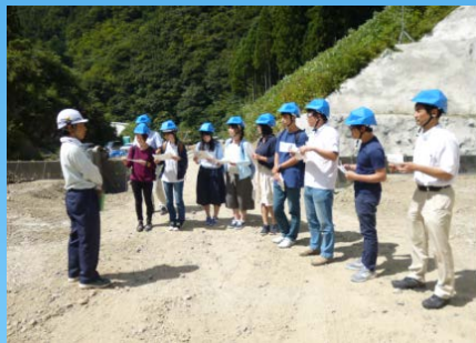
高地谷第1砂防堰堤では業者から工事説明を受けました。
