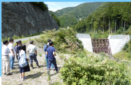
大蔵谷第1砂防堰堤では透過型の構造に多くの質問がありました。
