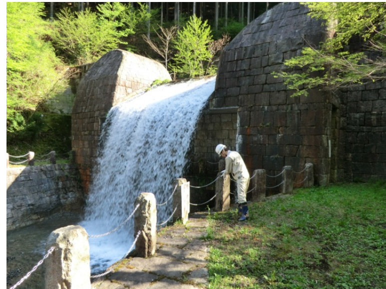
(鷲津谷第1砂防堰堤: 本巢市根尾神所)
