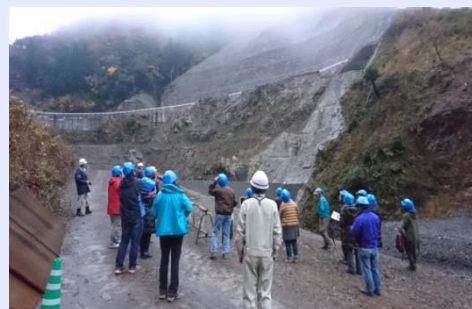
高地谷第1砂防堰堤工事現場
