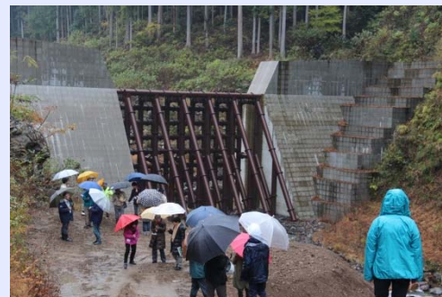
大蔵谷第1砂防堰堤
