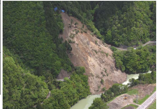
管内で発生した地すべり (H18 東横山地先)
