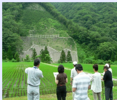
八草川山腹工事現場
