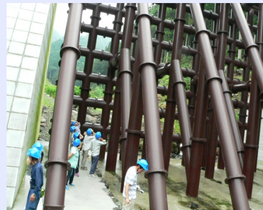
※大蔵谷第1砂防堰堤
