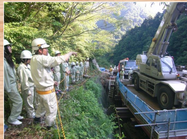
工事概要の説明(大谷川)
