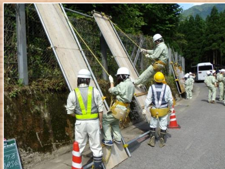
安全帯のぶら下がり体験
