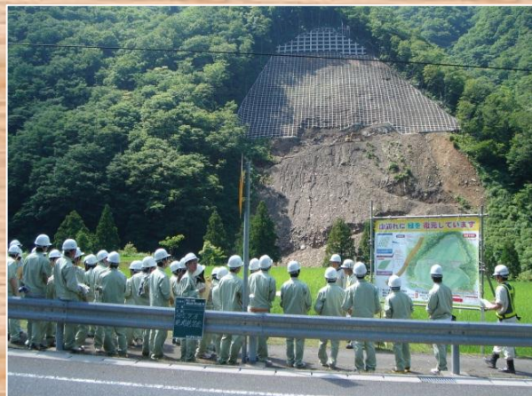
工事概要の説明(八草川)
