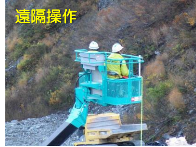
堰堤工（有スランプコンクリート打設）
