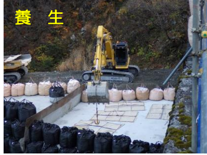
堰堤工（有スランプコンクリート打設）
