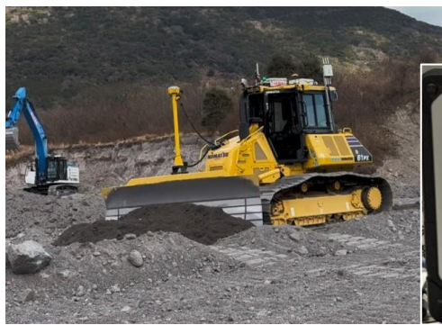
ブルドーザによる自動施工状況
