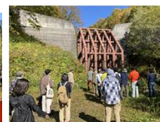
⑧小谷村砂防ダムツアー（里見2号砂防堰堤）
