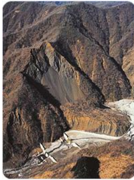
徳山白谷大崩壊地 昭和40年（1965年）
