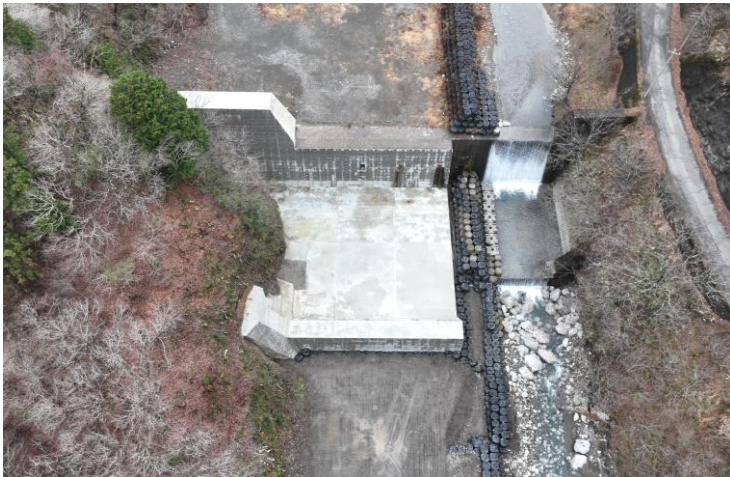
施工状況 令和8年3月
