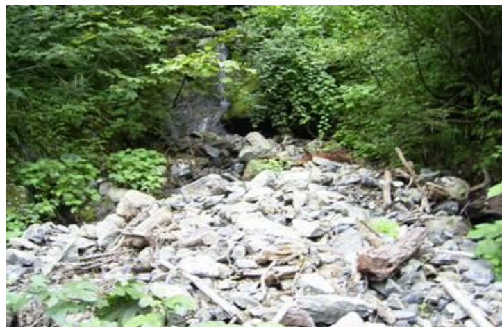
上流部の荒廃状況
