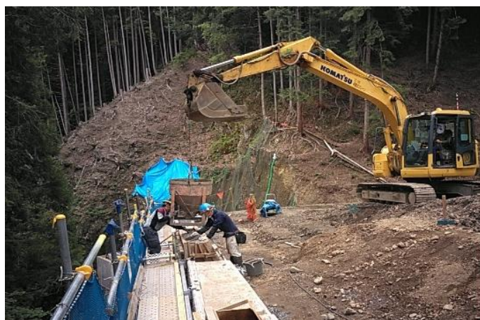
擁壁工 笠コンクリート打設状況 令和7年5月
