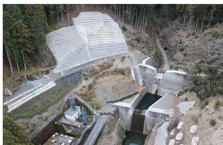
施工状況 令和8年3月
