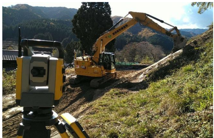
道路土工 ICT掘削状況 令和6年11月
