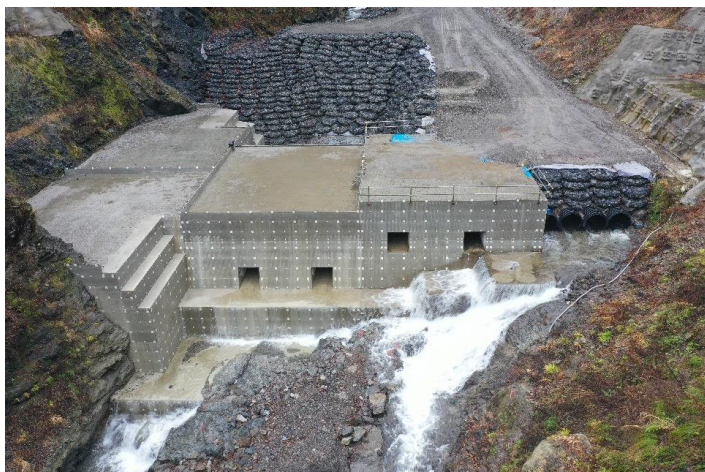
施工状況 令和8年3月
