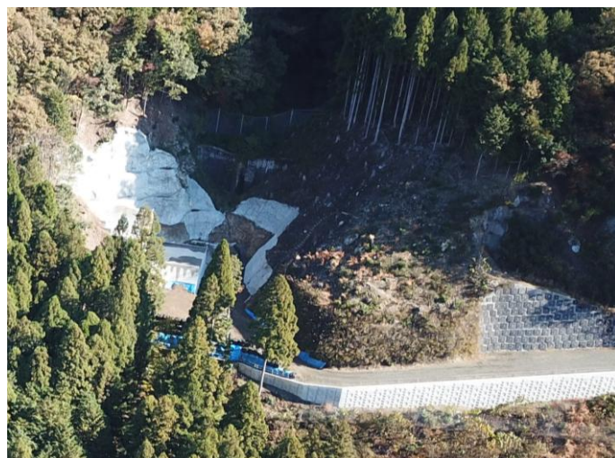
施工状況 令和8年3月
