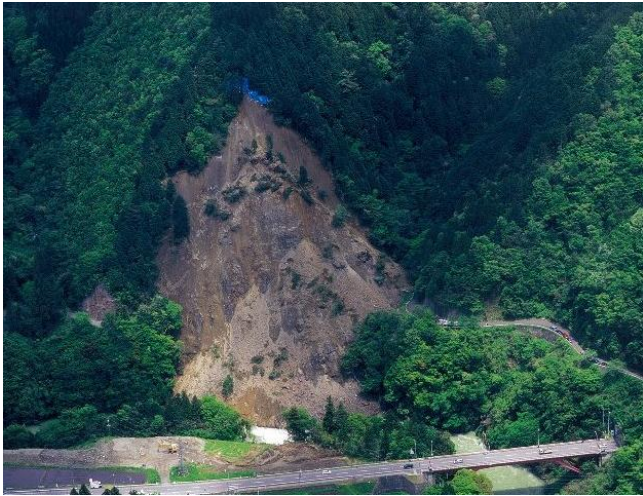
平成18年5月 東横山地すべり (2006年) (揖斐川町東横山)
