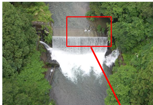
4Kカメラの画像から土砂や流木の堆積状況、砂防堰堤の変状等の有無を確認（サガド砂防堰堤）
