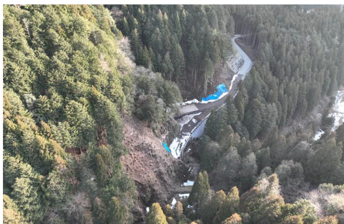
施工状況 令和8年3月
