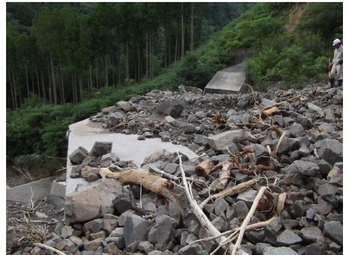
平成23年8月 土石流 (本巣市根尾越波) (2011年)
