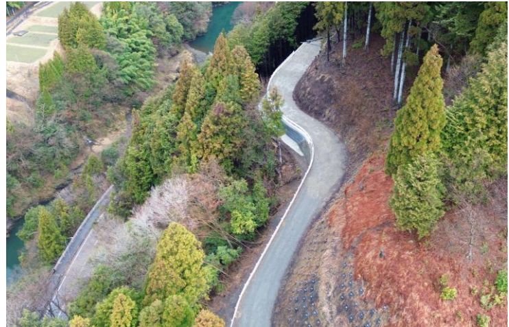
施工状況 令和8年3月
