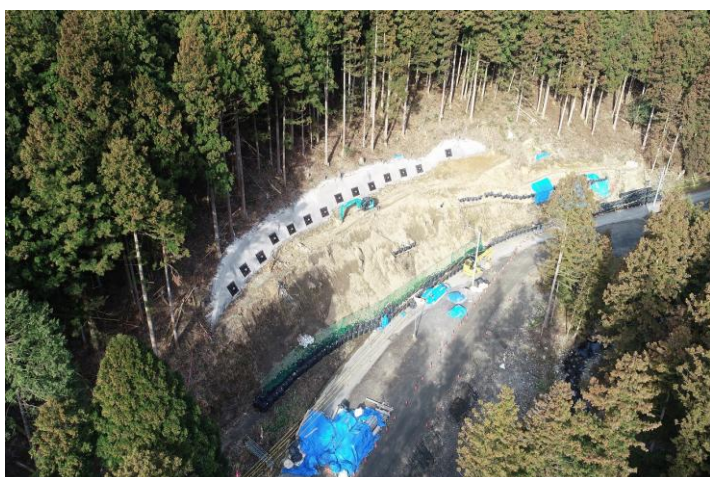
施工状況 令和8年3月
