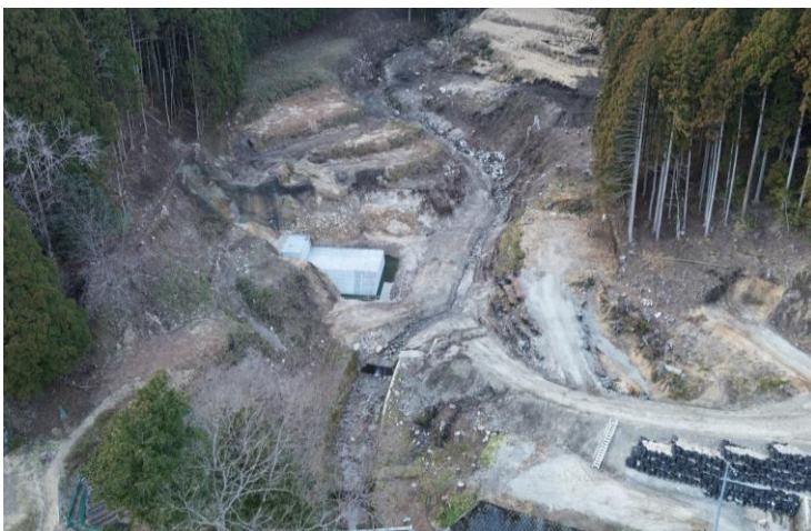
施工状況 令和8年3月
