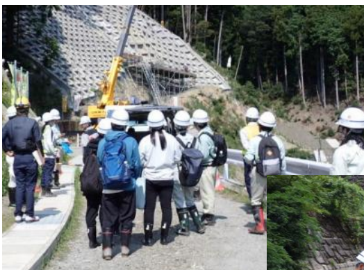
砂防堰堤工事の安全パトロール
