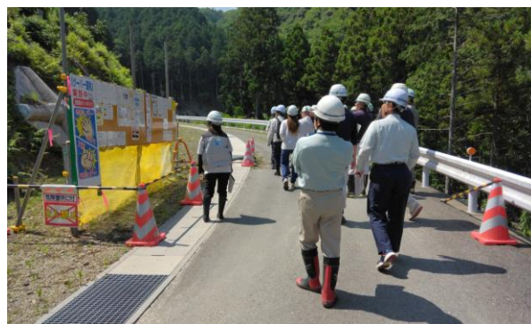
工事現場パトロールの状況（令和7年6月）
