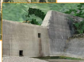
施設・溪流状況確認
