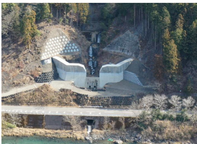
施工状況 令和8年3月
