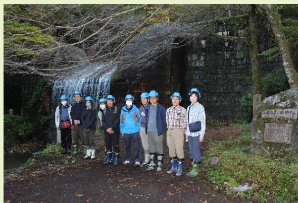
わしずたに 鷺巣谷第1砂防堰堤
