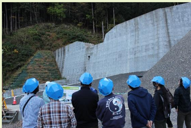
ガラン谷第1砂防堰堤工事現場
