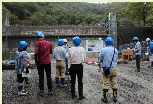
ナンノ谷砂防堰堤2号工事現場
