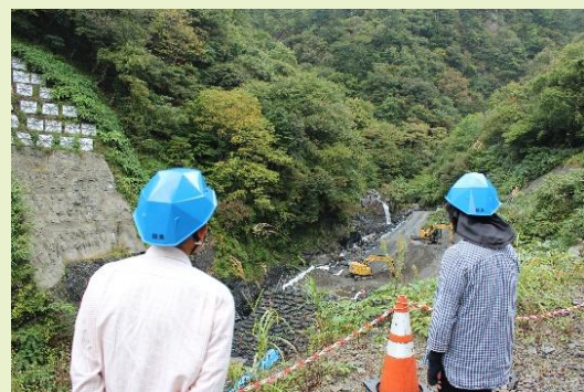
大谷川第3砂防堰堤工事現場
