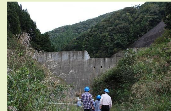
たかちたに 高地谷第1砂防堰堤
