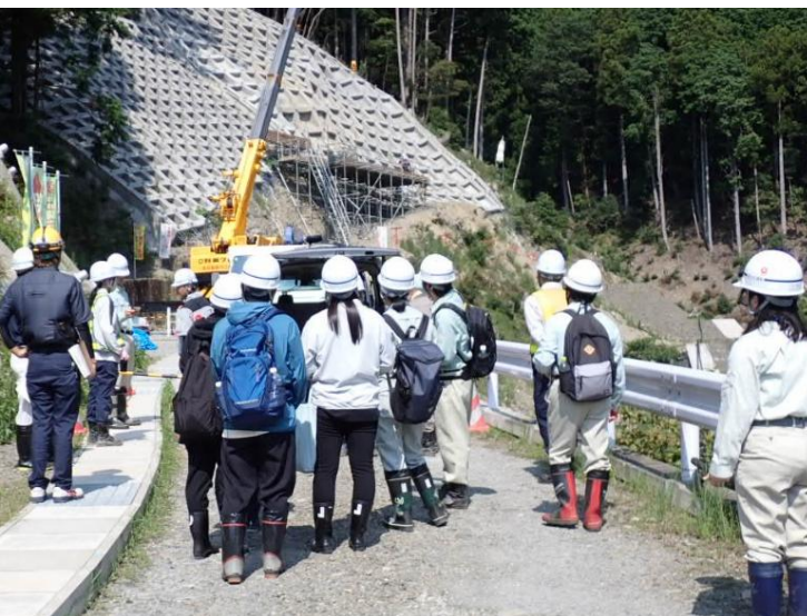
砂防堰堤工事の安全パトロール
