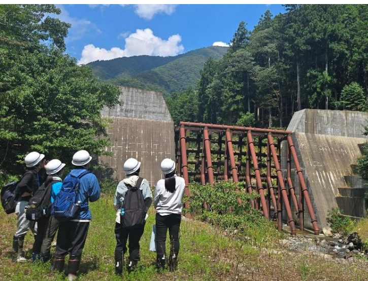
ドローンを使って砂防堰堤を上空から調査
