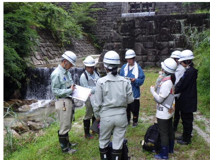
出水後の砂防堰堤の土砂と流木の捕捉状況などを調査
