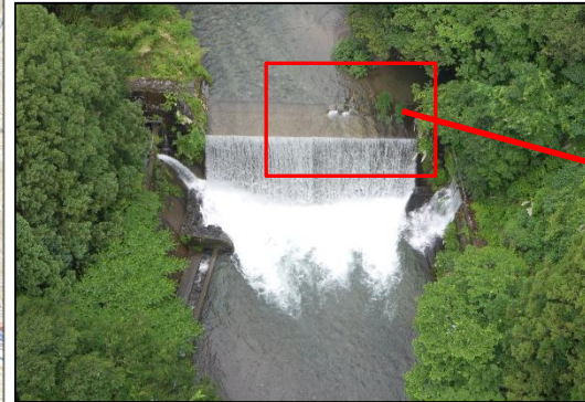
4Kカメラの画像から、土砂や流木の堆積状況、砂防堰堤の変状等の有無を確認(サガド砂防堰堤)
