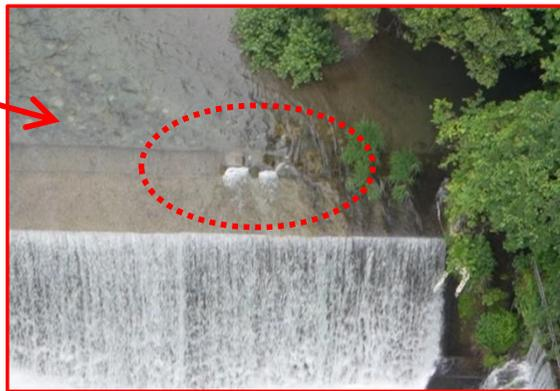
画像を拡大することで、水通し部の損傷(摩耗)を確認
