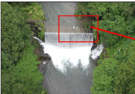
4Kカメラの画像から、土砂や流木の堆積状況、砂防堰堤の変状等の有無を確認(坂内砂防堰堤)
