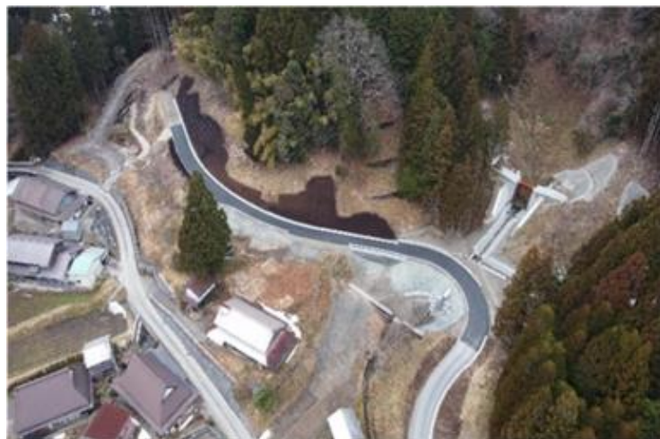
施工状況 令和7年3月
