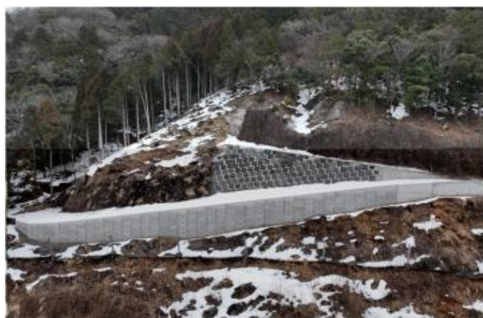
施工状況 令和7年3月
