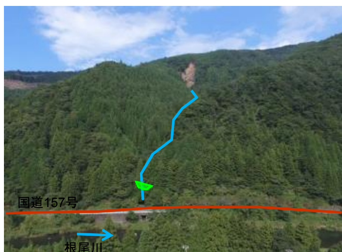
根尾川右岸より蛇抜谷を望む
