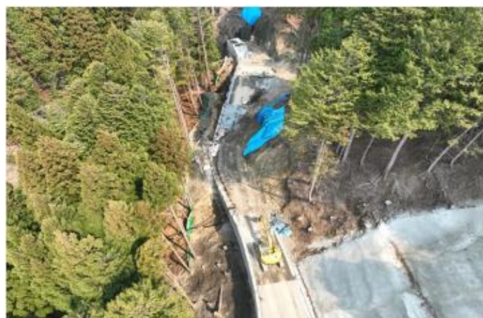
施工状況 令和7年3月末
