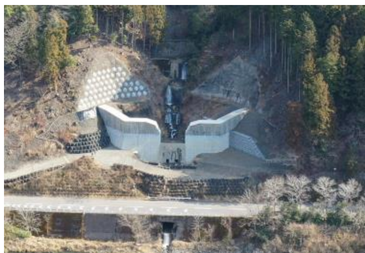
施工状況 令和7年3月
