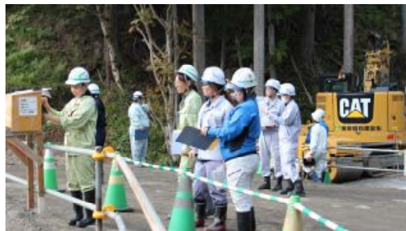
工事現場パトロールの状況（令和6年10月）
