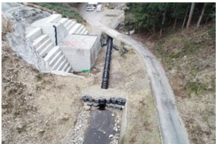
施工状況 令和7年3月
