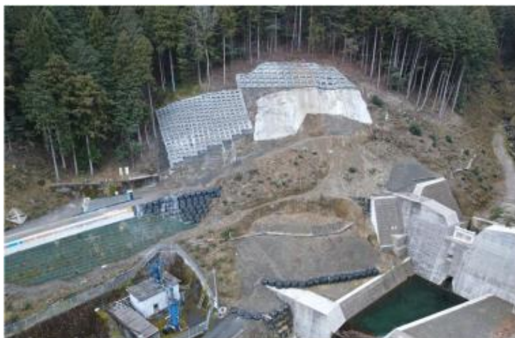
施工状況 令和7年3月
