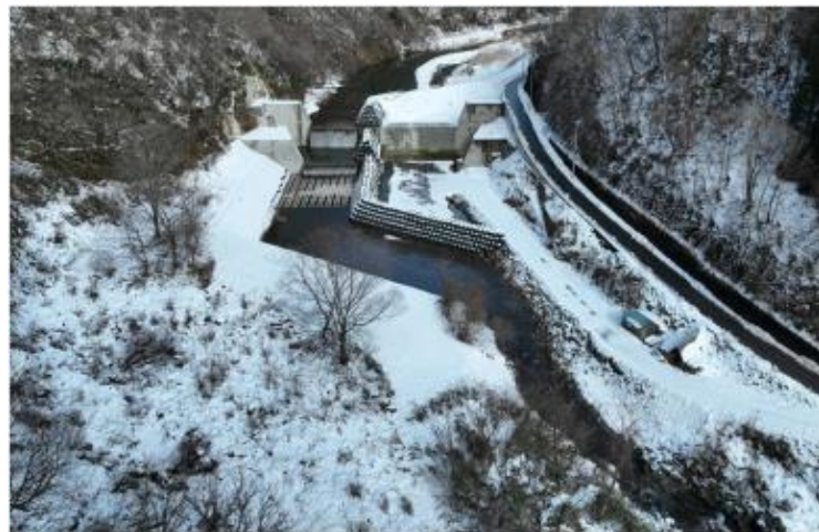
施工状況 令和7年3月
