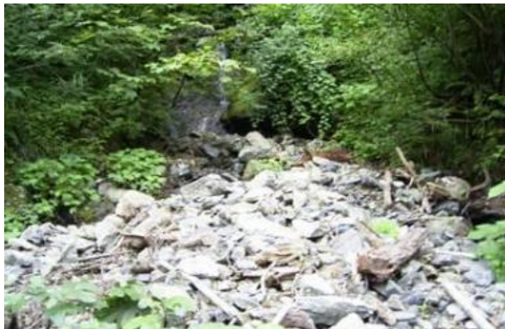
上流部の荒廃状況
