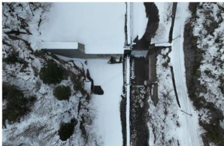
施工状況 令和7年3月
