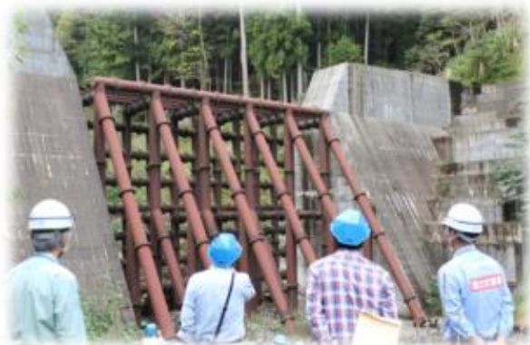
大蔵谷第1砂防堰堤見学
