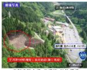
実証実験会場：堂洞第1砂防堰堤
