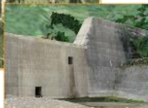
施設・溪流状況確認
