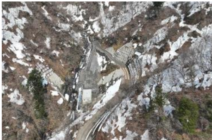
施工状況 令和7年3月
