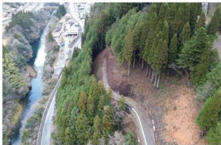
施工状況 令和7年3月
