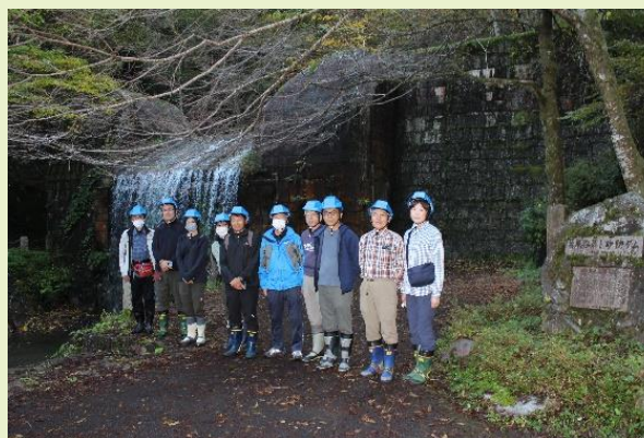
わしずたに 鷲巣谷第1砂防堰堤
