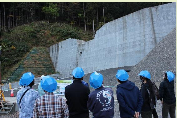
ガラン谷第1砂防堰堤工事現場
