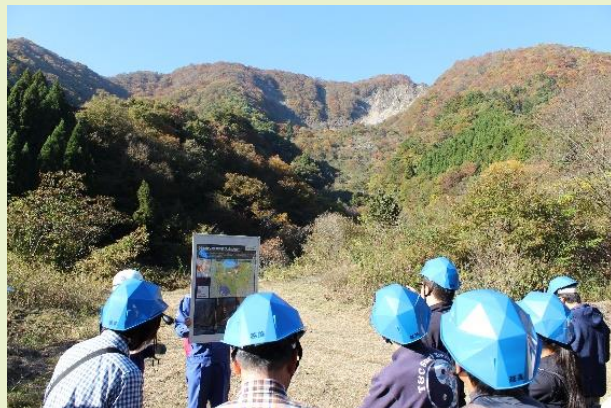
根尾白谷大崩壊地
