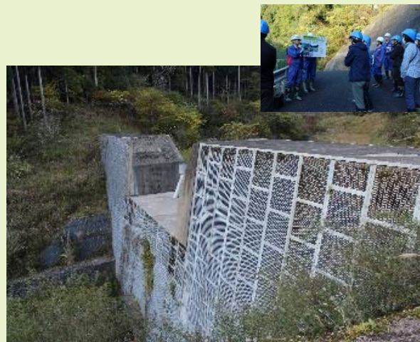
しきはらたに 敷原谷第1砂防堰堤
