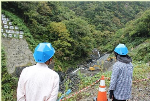
大谷川第3砂防堰堤工事現場
