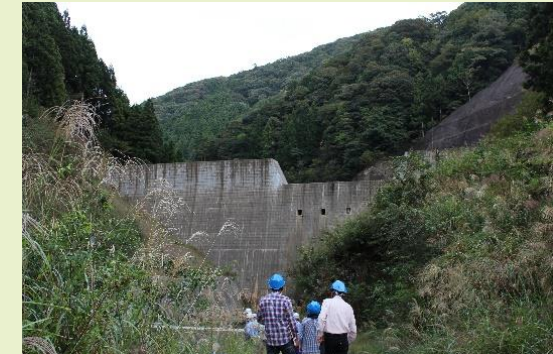
たかちたに 高地谷第1砂防堰堤
