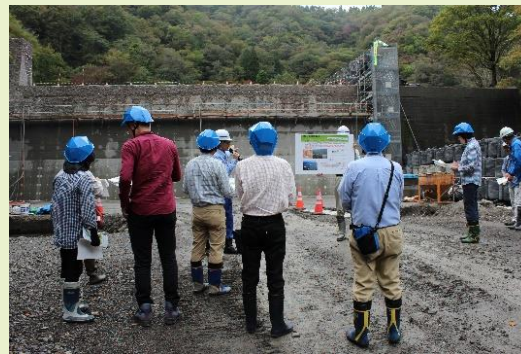
ナンノ谷砂防堰堤2号工事現場
