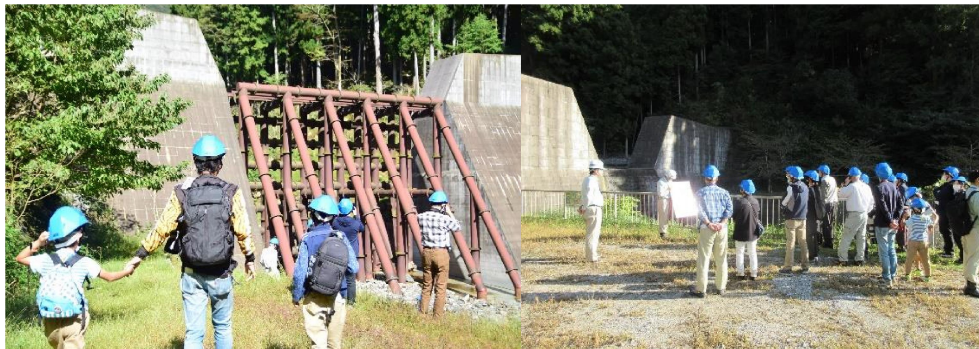
大蔵谷第1砂防堰堤
