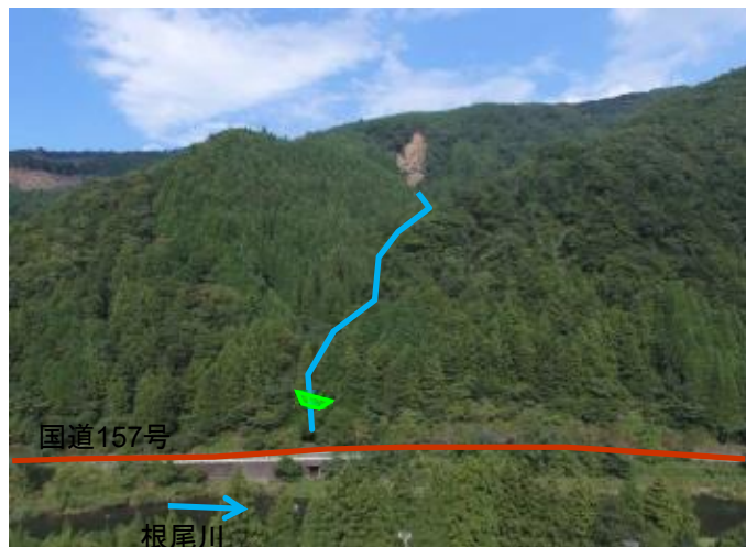
根尾川右岸より蛇抜谷を望む
