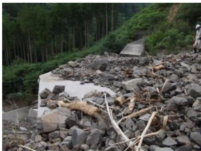
平成23年8月 土石流 (本巣市根尾越波) (2011年)
