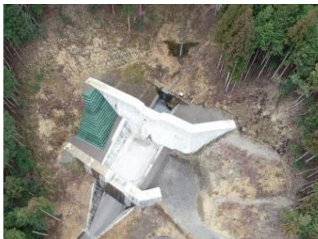
施工状況 令和6年3月末
