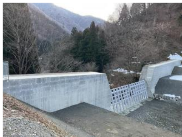
大谷川第1砂防堰堤 令和5年3月 流木止め設置
