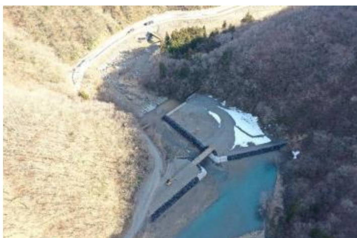
施工状況 令和6年3月末
