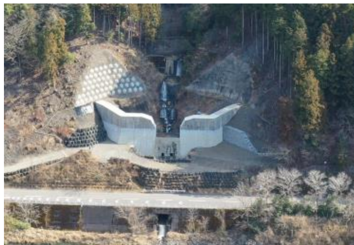
施工状況 令和6年3月末
