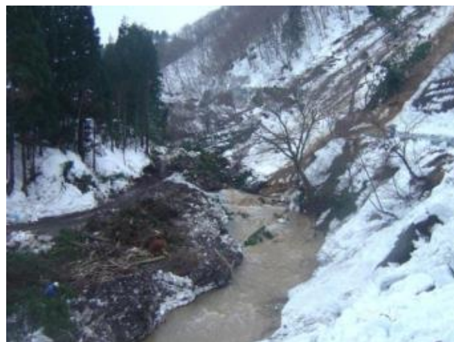
平成22年1月 八草川山腹崩壊 (2010年) (揖斐川町坂内川上)
