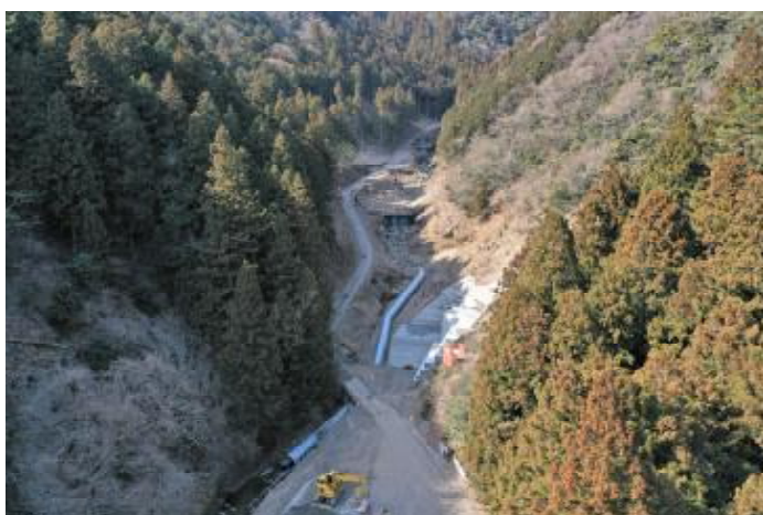
施工状況 令和6年3月末
