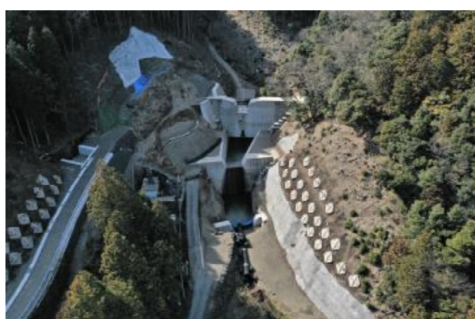
施工状況 令和6年3月末
