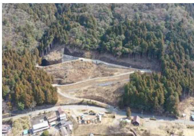
施工状況 令和6年3月末
