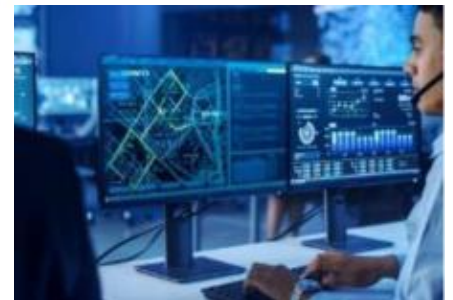
遠隔操作・監視
