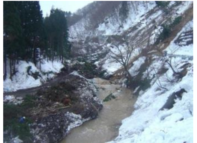
平成22年8月 八草川山腹崩壊 (2010年) (揖斐川町坂内川上)
