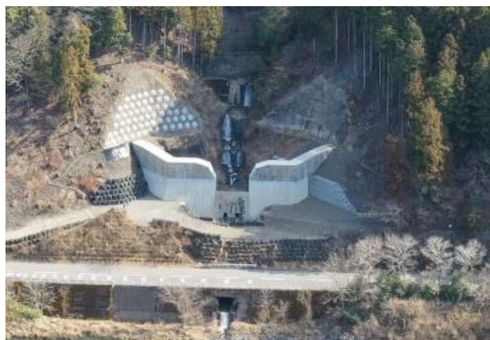
施工状況 令和6年3月末
