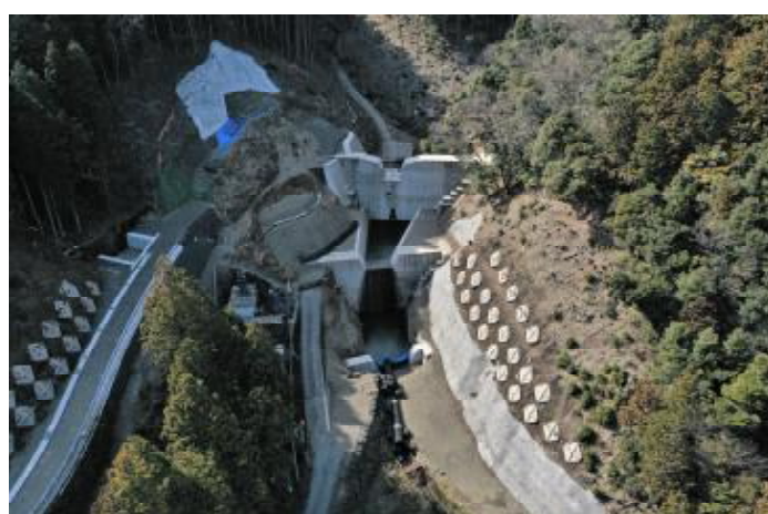
施工状況 令和6年3月末
