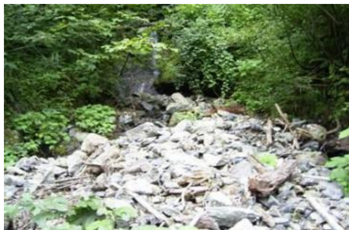
上流部の荒廃状況
