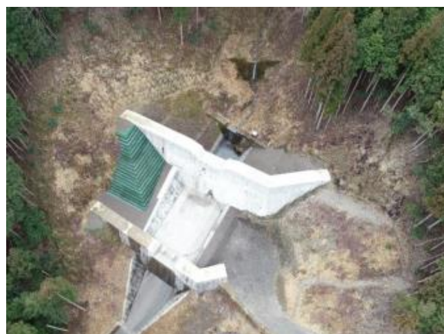
施工状況 令和6年3月末
