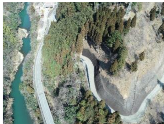
施工状況 令和6年3月
