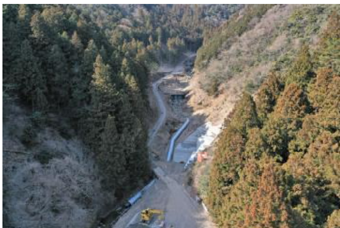
施工状況 令和6年3月末
