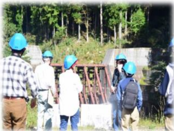
大蔵谷第1砂防堰堤見学
