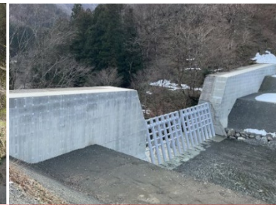
流域流木対策施設の設置(大谷川第1砂防堰堤)
