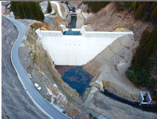
高地谷第1砂防堰堤
