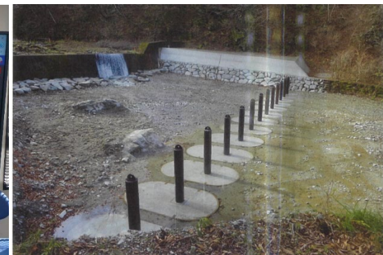
流木対策事例紹介：R2大河原(角巻谷) 流木防止総合対策治山工事
