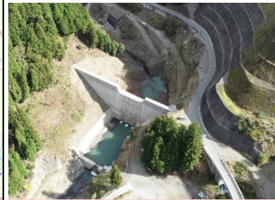
砂防堰堤等の整備(高谷第1砂防堰堤)
