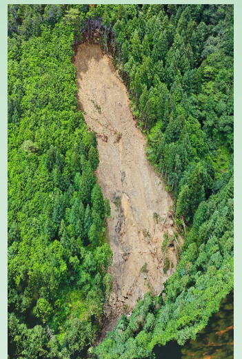
被災現場の3次元モデル
