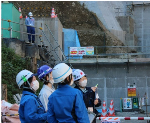
安全パトロールの状況
