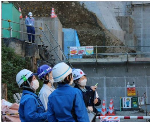
安全パトロールの状況
